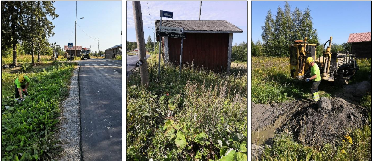
Vasen: suuntaporausta seurataan, kuvan suunta koilliseen. Keskimmäinen: kohta johon poraus arviolta keskeytyi, kuvan suunta lounaaseen. Oikea. Työ päättyi ja pora vedettiin pois.
